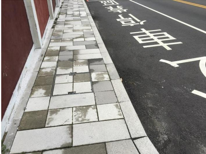
圖 2 人行鋪面(高壓混凝土地磚)、道路鋪面(標線、瀝青混凝土鋪面)
