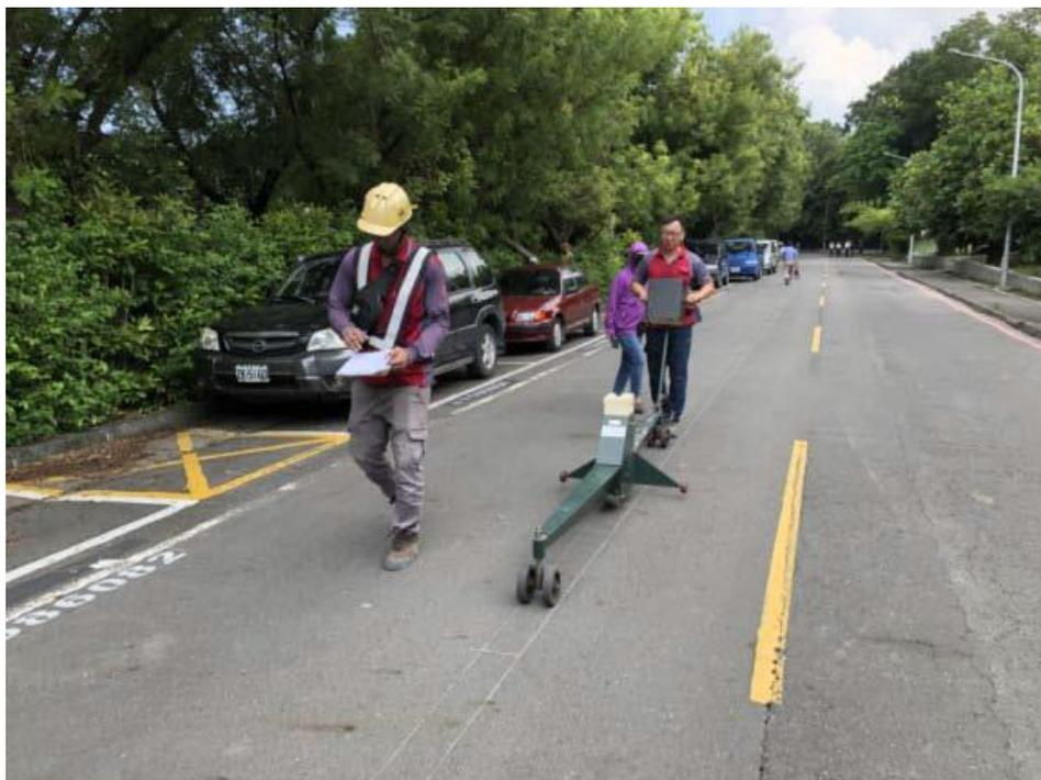
圖1 瀝青混凝土鋪面平坦度現地檢測
