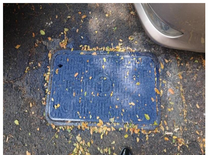
圖 4 手孔蓋施予塗料提升防滑性能
