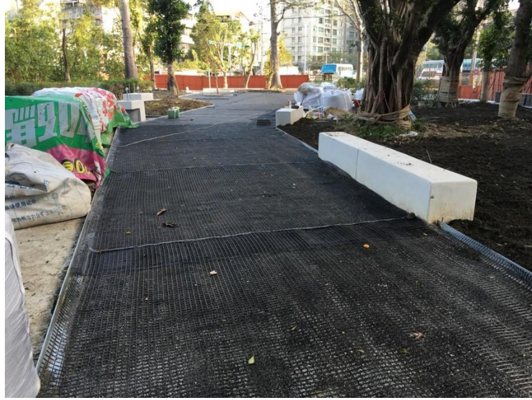
圖 7 鋪面底層採用地工格網利於排水及透水
